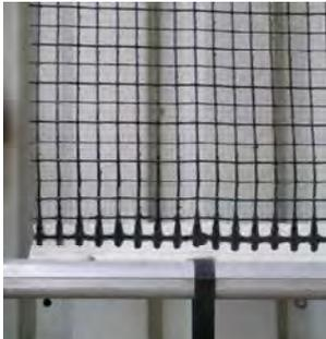
Netzverspannung mit dem Kederrohr
