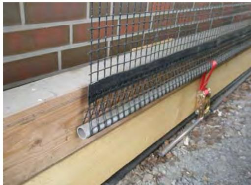
Netz-Verspannung mit einem Rohr im Hohlraum
